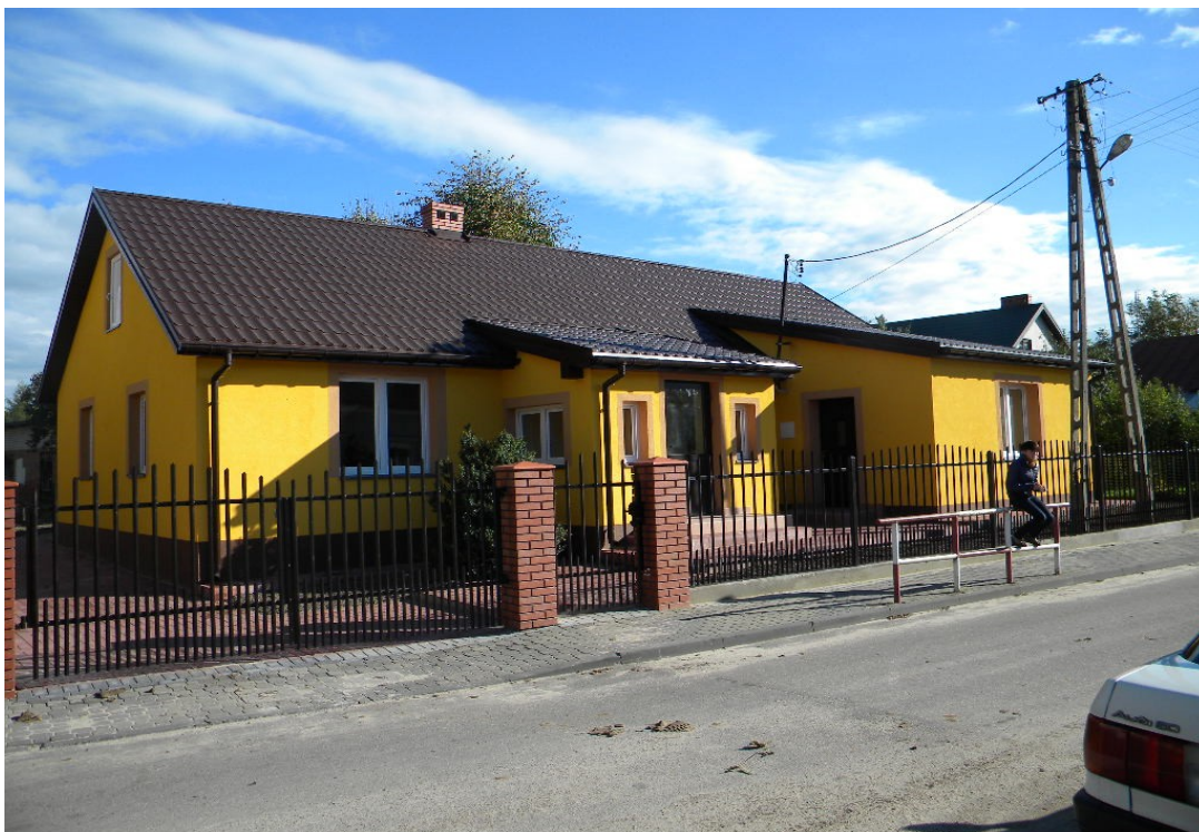
Świetlica wiejska w Serokomli po remoncie
