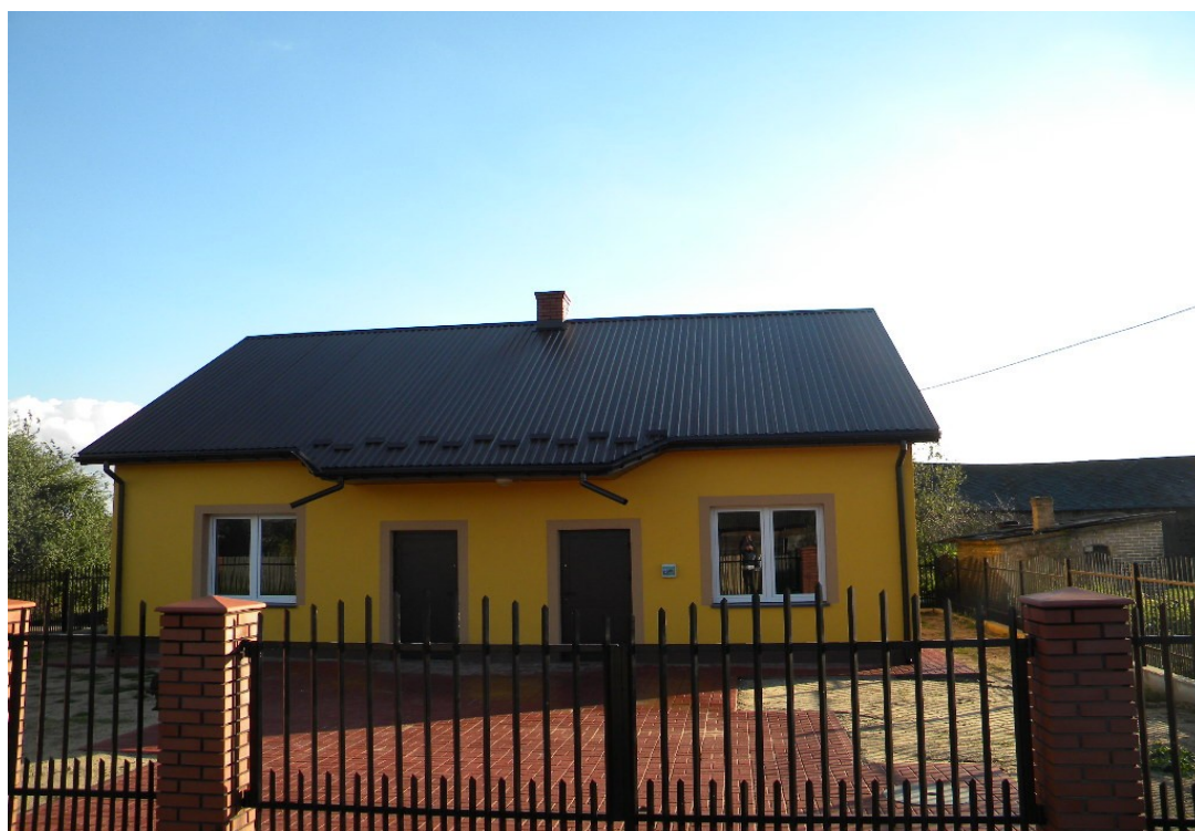
Nowo wybudowana świetlica wiejska w Poznaniu
