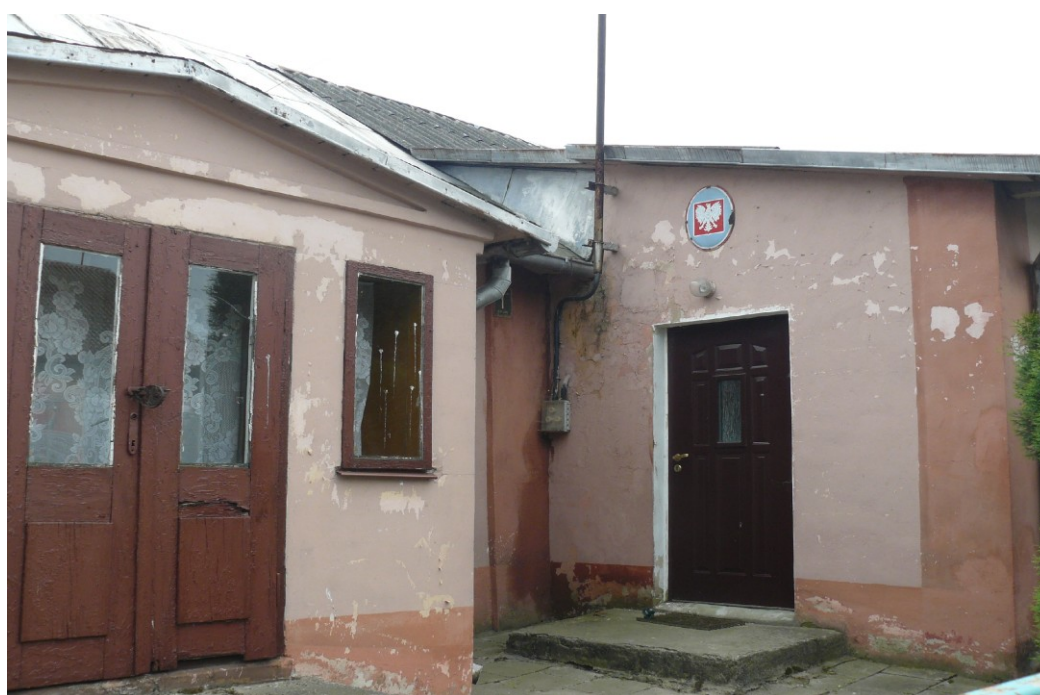
Świetlica wiejska w Serokomli przed remontem
